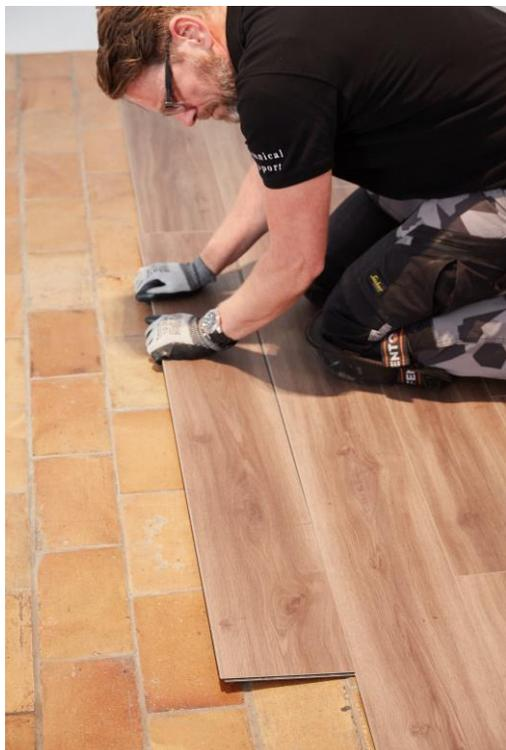
Zum Einfügen der letzten Plankenreihe müssen die Planken in der Regel zugeschnitten werden. Legen Sie dazu eine Planke deckungsgleich auf die vorletzte Reihe, legen Sie eine weitere Planke obenauf und positionieren Sie diese mit der Außenseite direkt zur Wand. Zeichnen Sie ihre Vorderkante auf der Diele darunter ein. Berücksichtigen Sie dabei den einzuhaltenden Randabstand. Jetzt können Sie diese Planke passend zuschneiden und zusammen mit den anderen Planken der letzten Reihe einrasten.
